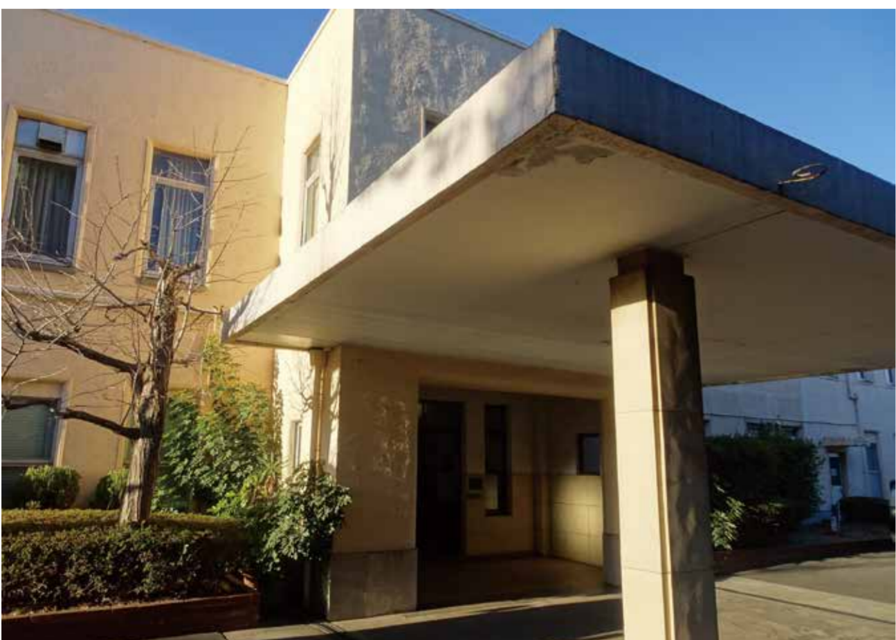
昭和電工川崎工場本事務所(国登録有形文化財/提供:株式会社レゾナック川崎事業所)。昭和6(1931)年に建てられた、昭和初期の工場事務所建築の代表的な様式で、内部には、吹き抜けの階段やステンドグラスなどの意匠が施されている
