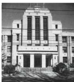
従前：東京簡易保険事務センター （旧逓信省簡易保険局） 出典 『港区の歴史的建造物』
