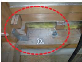
柱と土台を固定します
