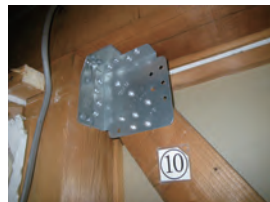
梁や柱と筋かいを固定します
