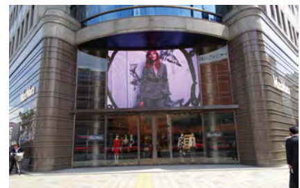
○ 建築物のデザインに合わせて低層部に設置したLEDビジョンの例
