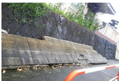
ブロック塀の被害（出典：熊本地震デジタルアーカイブ）
