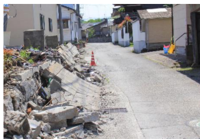
ブロック塀の被害（出典：熊本地震デジタルアーカイブ）
