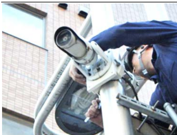
▶ 保守点検の様子
