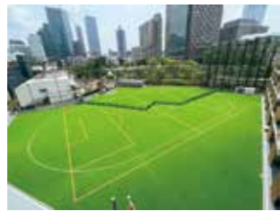
間もなく校庭・園庭が完成
