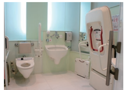
多目的トイレ
