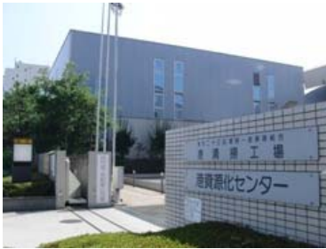
港資源化センターの外観
