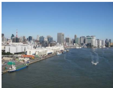
埋立地に整備された港湾施設 (海岸二、三丁目)
