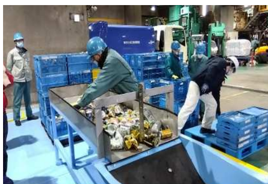
令和4（2022）年度に設備更新を行った 港資源化センター
