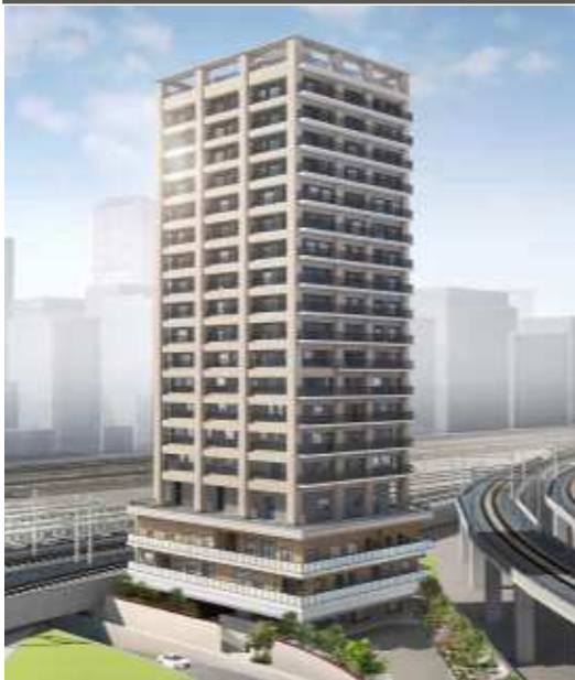
区民向け住宅、認可保育園、障害者グループホーム、 小規模多機能型居宅介護施設等 令和7(2025)年度竣工予定
