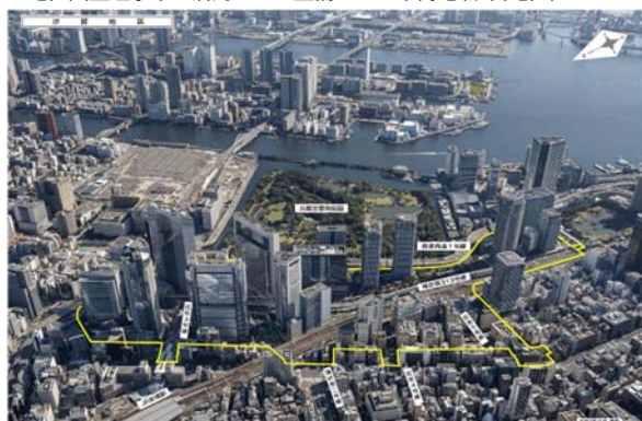
土地地区画整理事業の活用により整備された市街地(汐留地区)
