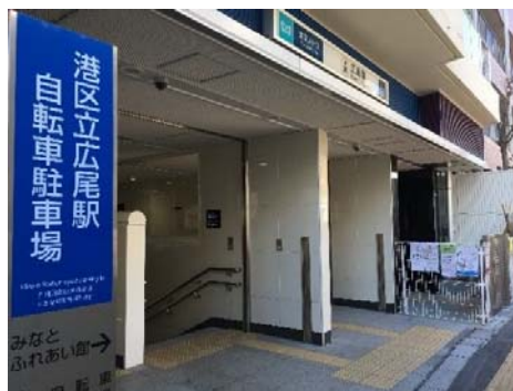
区有地を活用した地下鉄駅バリアフリー化事例
