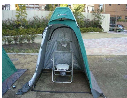
マンホールトイレ
