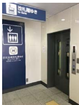
地下鉄エレベーター設置
