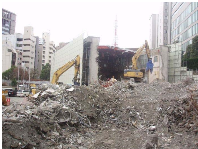
解体工事の様子
