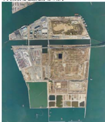
中央防波堤埋立処分場の様子
