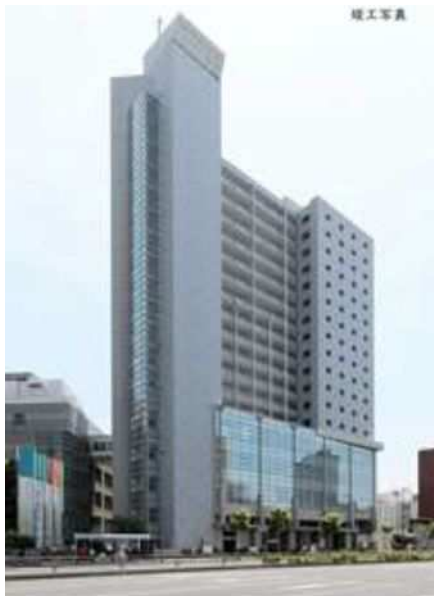
大規模改修工事を行った高輪コミュニティがらざ
