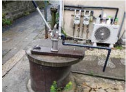
路地を抜けると井戸がある
