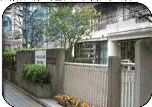
旧園舎 鉄筋コンクリート造 2階建 (地下1階、地上3階建) 延 1319.38 m 2
