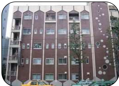
旧園舎 鉄筋コンクリート造 5階建(児童館・保母寮併設) 保育園 1、2階部分 延 744.08 m 2
