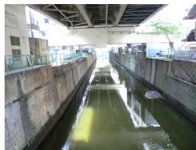
高速道路の高架下 となっている古川
