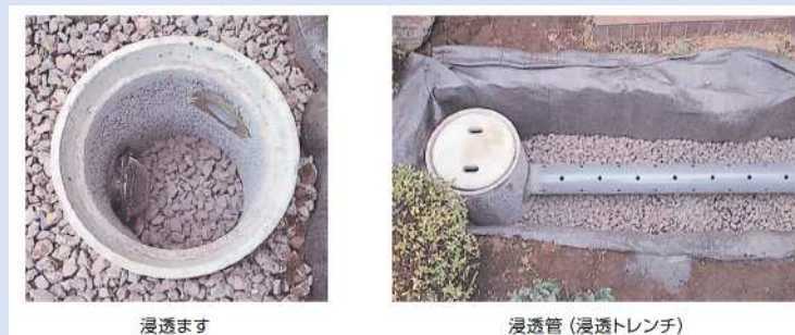
図 5-27 雨水浸透施設の例
