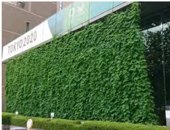
図 5-19 区役所本庁舎に設置した緑のカーテン
