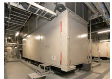
ガスエンジンコージェネ (赤坂インターシティAIR)
