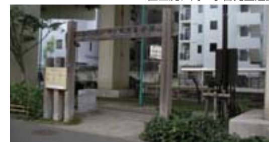
防犯上、懸念される高速道路高架下 区立中ノ橋児童遊園遊園
