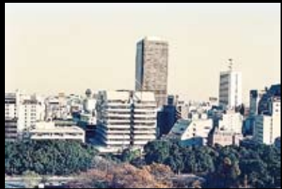
昭和61(1986)年 工事が進む新庁舎
