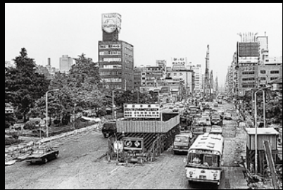
昭和45(1970)年 地下鉄工事(増上寺前)
