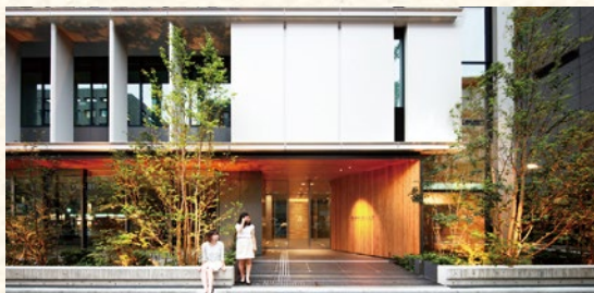
銀泉新橋第2ビル(新橋 5-1-9)
