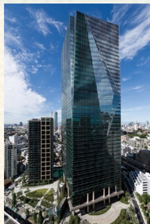
住友不動産六本木グランドタワー、六本木グランドタワーレジデンス、六本木グランドプラザ
