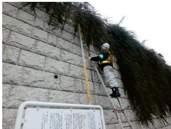
道路構造物（よう壁）を診断している様子
