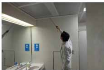
建築基準法に基づく点検
