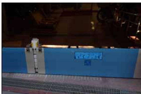
止水板を設置した様子
