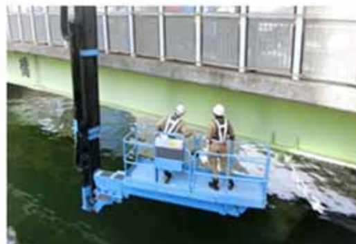
リフト車により、橋桁の状況を確認
