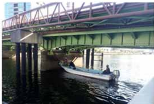
台船から橋脚の状況を確認
