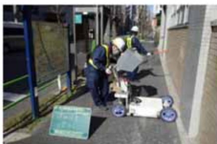
道路下空洞調査
