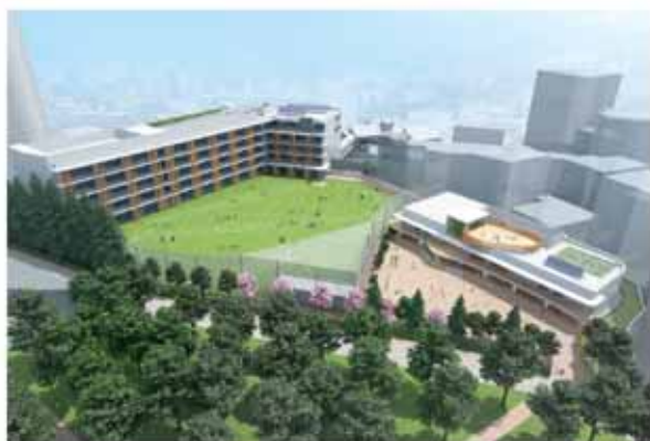
港区立赤坂中学校等整備工事
