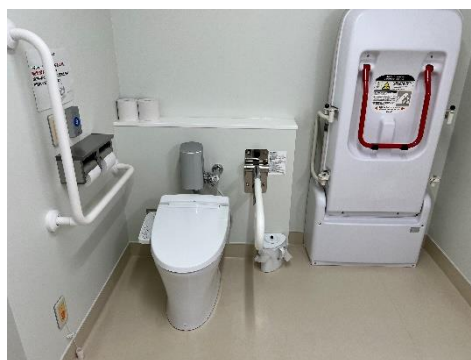
バリアフリートイレの改修 〈生涯学習センター（ばるーん）〉
