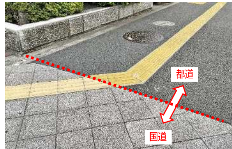
管理者を跨いだシームレスなバリアフリー経路確保の好事例
