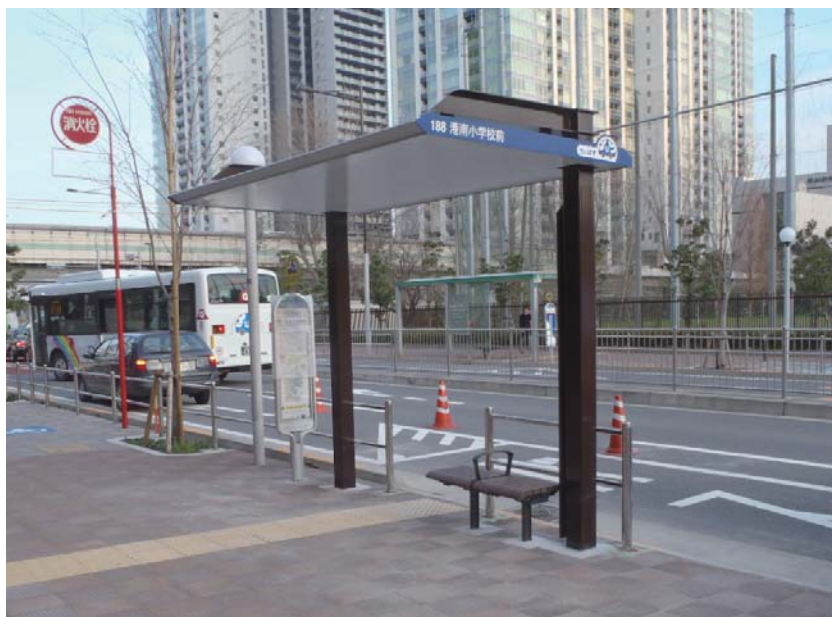
図 10-12：バス停に屋根とベンチの設置
