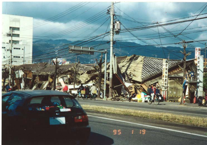
阪神・淡路大震災の被害状況
