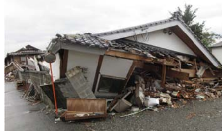
熊本地震の被害
