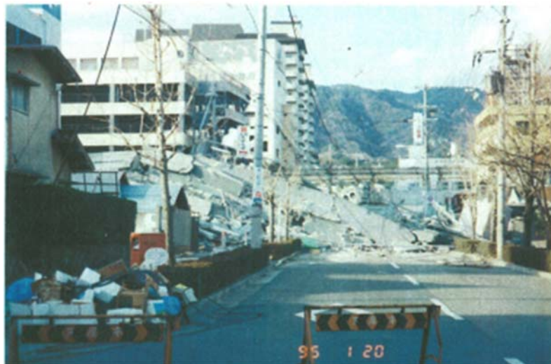
倒壊したビルが道路を閉塞した例 阪神・淡路大震災
