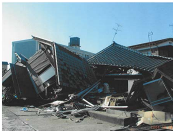
全壊した住宅 新潟県中越地震
