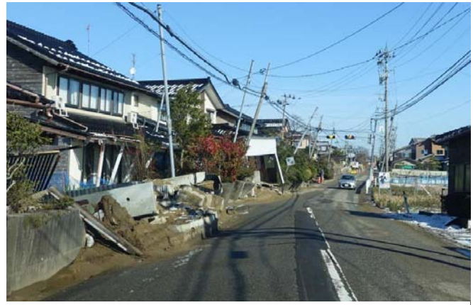
令和 6 年能登半島地震の被害状況
