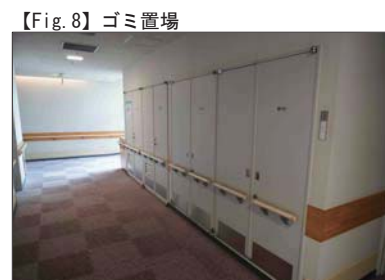
【Fig. 8】ゴミ置場 物入れの一部はゴミ置場として利用。
