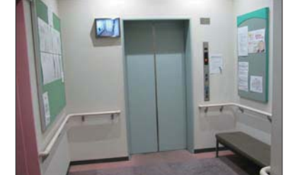
手すりは抗菌性、耐薬品性に取替。 写真は(5階)(5~8階共通)
