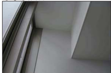
【Fig.4】 非常用エレベーターロビー
