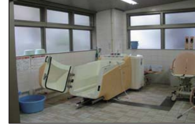
内部仕上に汚れあり、排水溝の範囲が変更済。
