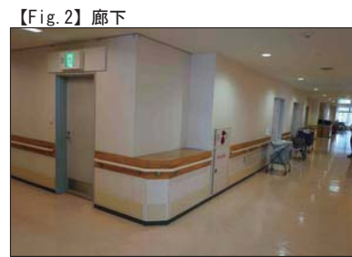
【Fig.2】廊下 消火用散水栓があり、壁の範囲が変更済。(2~4階)
