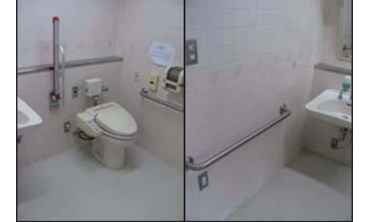
【Fig.10】デイルーム内車椅子便所
