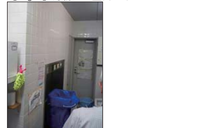
パイプスペース用扉設置済。(2~4階)
