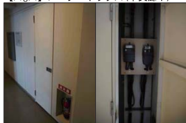
メーターボックス扉と内部の様子。 塗装や機器の更新。
