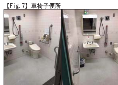
【Fig. 7】車椅子便所 内部のトイレ配置変更済。
