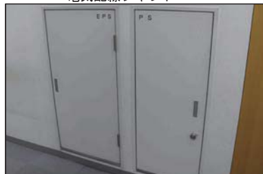
【Fig.4】パイプスペース 電気配線シャフト
