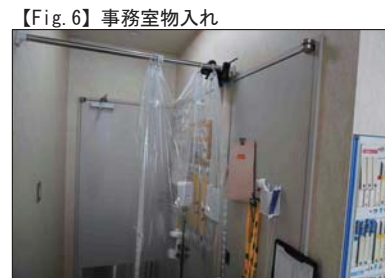
【Fig. 6】事務室物入れ 室内にパイプスペース用建具あり。
