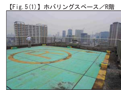
屋上サインの向きが反転済、方向表示あり。
