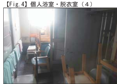
【Fig. 4】個人浴室・脱衣室(4) 倉庫利用。女性用は個人浴室の更新、男性用は倉庫へ改修とする。
