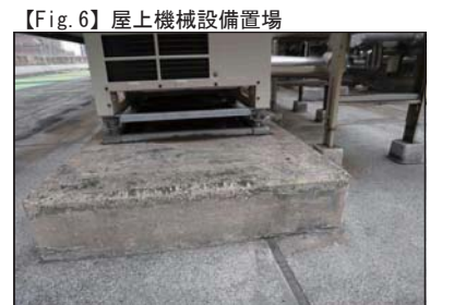
冷却塔ブレード用機械基礎あり。
