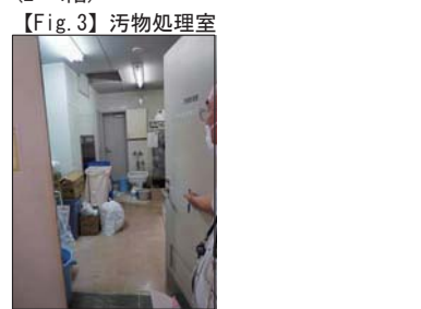
【Fig.3】汚物処理室 建具の向き、排水溝計画が変更済。(2~4階)
