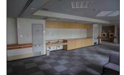
可動式防煙垂壁あり。(6~8階)
