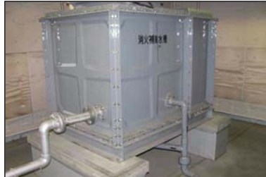
【Fig.3】消火用中間水槽
