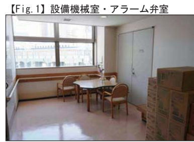
【Fig.1】設備機械室・アラーム弁室 建具が親子扉に変更済。(2~4階)
