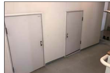
【Fig.8】 集会室前ホール 電気配線シャフト ・パイプスペース扉
