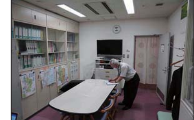
小会議室、館長室へ改修済、間仕切り壁撤去済。
