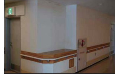
消火用散水栓があり、壁の範囲が変更済。(2~4階)
