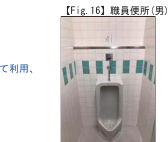
小便器設置済 (既存図になし)
