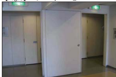
中央廊下側、防火折戸をみる。
