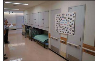
下部収納開放、建具は上部のみ。(2~4階)
