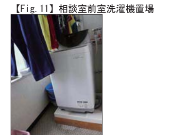
【Fig. 11】相談室前室洗濯機置場 既存図の便所がなく、防水パン設置済。
