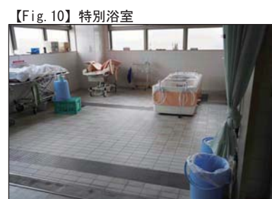
【Fig.10】特別浴室 排水溝計画変更済。(2~4階)
