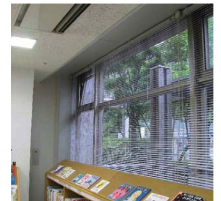
港南図書館 窓面
