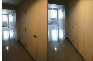
左) 24階片開き扉H2,000以上、 右) 23階片開き扉H1,250、階により形状が異なる。
