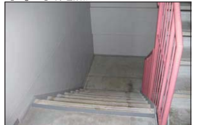
中央部は鉄骨造手すり、壁側手すりなし。
