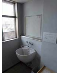
パイプスペース扉あり。(6~8階)
