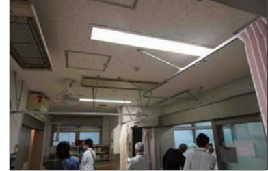
天井カーテンレール設置済。
