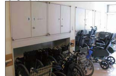
下部収納開放、建具は上部のみ。(2~4階)
