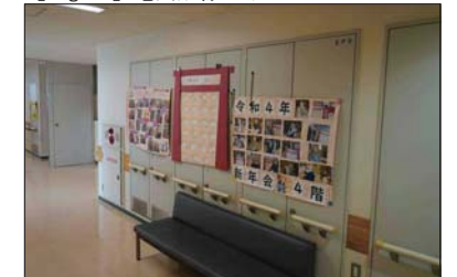
【Fig.16】電気配線シャフト 電気配線シャフト用の扉は2箇所から3箇所に変更済。(2~4階)
