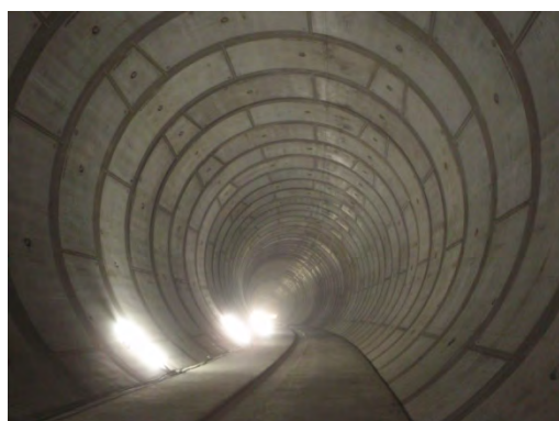
完成した古川地下調節池トンネル (東京都第一建設事務所ホームページより)
