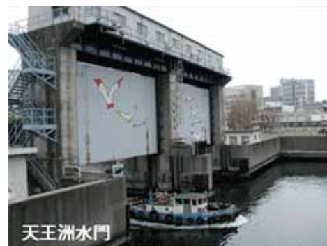
天王洲水門 出典：東京港湾事務所 HP「水門・排水機場」
