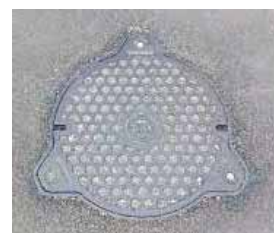
マンホールの蓋開き防止対策 出典：国土交通省「荒川水系（埼玉ブロック）流域治水プロジェクト事例集」
