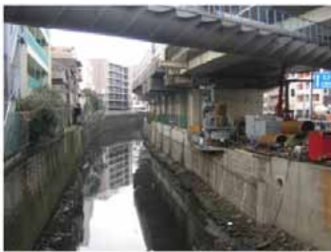
古川の護岸整備状況（古川橋上流側） 出典：東京都 HP「古川整備工事（その9）」
