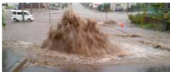
マンホールからの吹き上がり 出典：北見市 HP「北見市の浸水対策（第61回下水道の日）」
