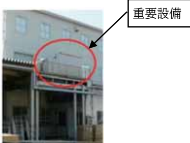
重要設備の高所配置
