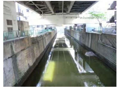
高速道路の高架下となっている古川
