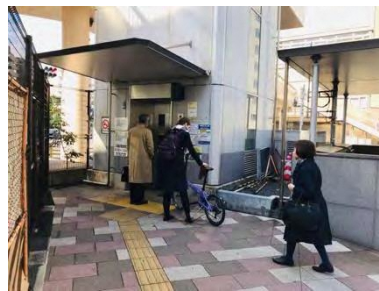
白金高輪駅に接続する エレベーター
