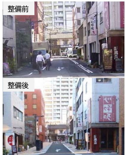
電線類地中化した事例 (浜松町二丁目)
