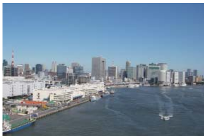
埋立地に整備された港湾施設 （海岸 2・3 丁目）
