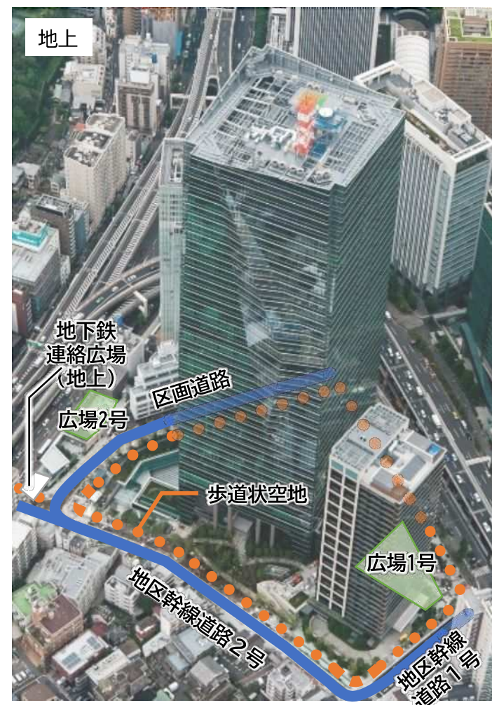
□整備した公共施設等
