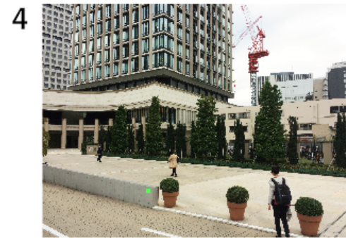
4 計画地北東は三田ベルジュビルのメインエントランスへ続く通路と地下駐車場へと続くスロープが設置されている。
