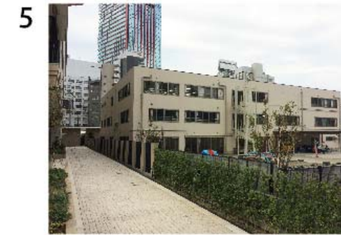
5 計画地南東は三田ベルジュビルの通路となっている。
