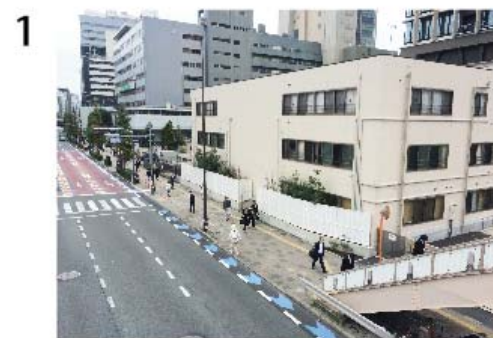
1 札の辻交差点には歩道橋がかけられており、計画地西角部に階段が設置されている。
