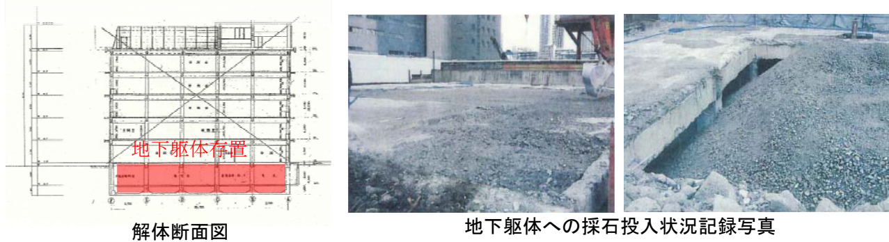
＜旧東京都港都税事務所解体工事状況＞
