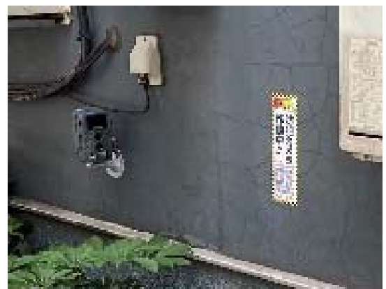
防犯カメラ設置の状況
