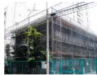
屋根全体が白い防水シートで覆われた協働会館
