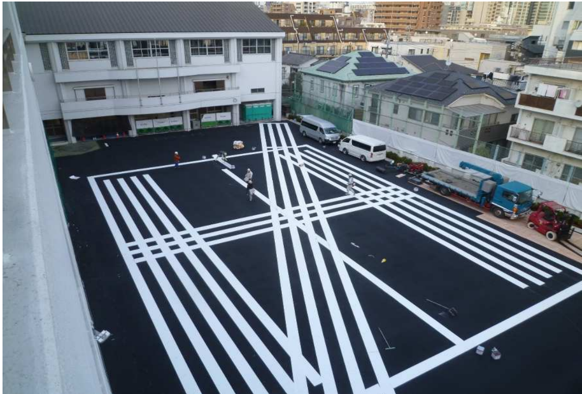
撮影月日 令和6年1月10日 写真説明 屋外グラウンド改修状況
