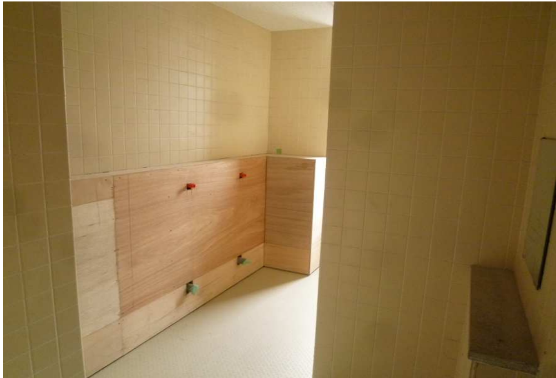
撮影月日 令和6年1月10日 写真説明 内装改修状況 (5F トイレ)
