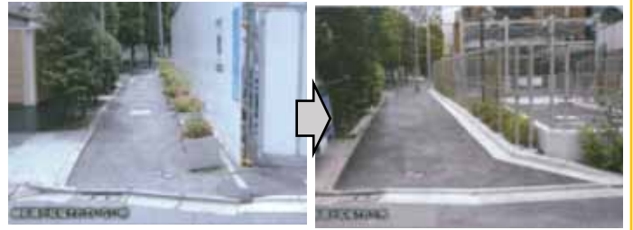
細街路拡幅前
