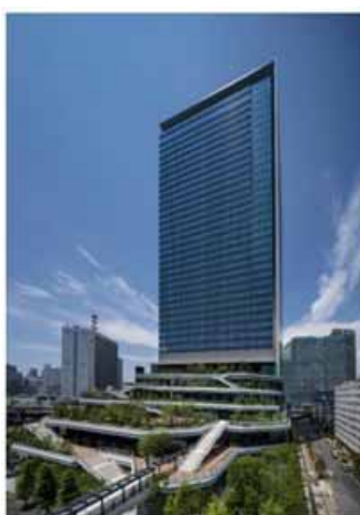
区内で民間初の津波避難ビル (東京ポートシティ竹芝オフィスタワー) 出典：東京ポートシティ竹芝 HP
