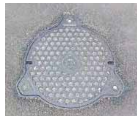
マンホールの蓋開き防止対策
