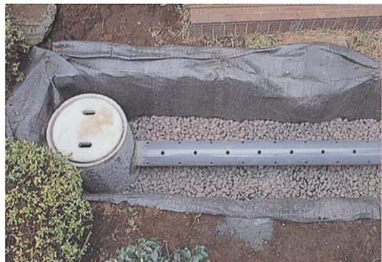
雨水浸透施設の浸透管（浸透トレンチ）
