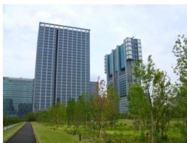
芝浦水再生センターの上部利用施設
