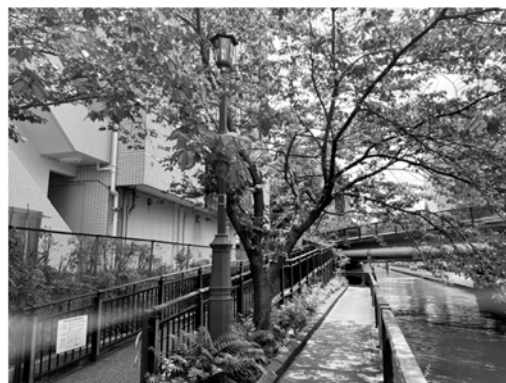
新芝運河沿緑地 照明器具取替
