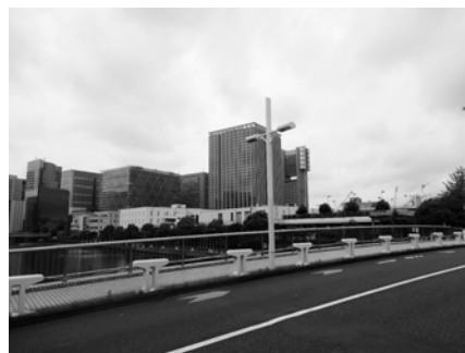
浜路橋（工事完了後）
