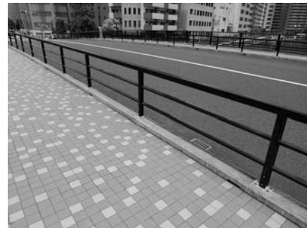
夕凧橋（工事完了後）
