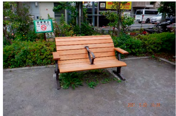
南青山四丁目緑地 ベンチ座板交換
