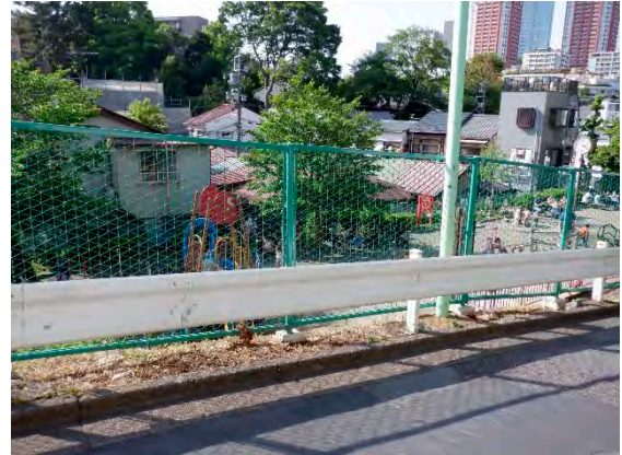
宮村児童遊園（転落防止柵設置）
