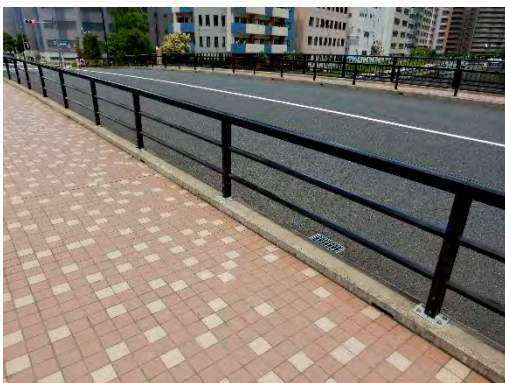
夕凧橋の防護柵建替
