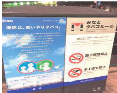
■配電ボックスの啓発表示
