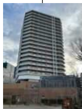
都営住宅棟 (令和元年12月竣工)
