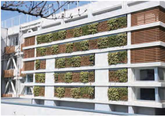
木製のルーバーをつかって壁面緑化しています
