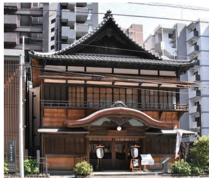
港区立伝統文化交流館 港区芝浦1-11-15 港区指定有形文化財である「旧協働会館」を改修して令和2(2020)年にオープンした多機能施設。展示室や憩いの間のほか「百畳敷」と呼ばれる舞台付きの大広間がある
