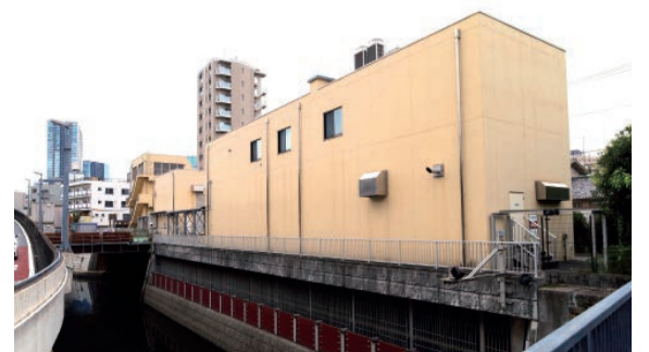
取水施設外観
