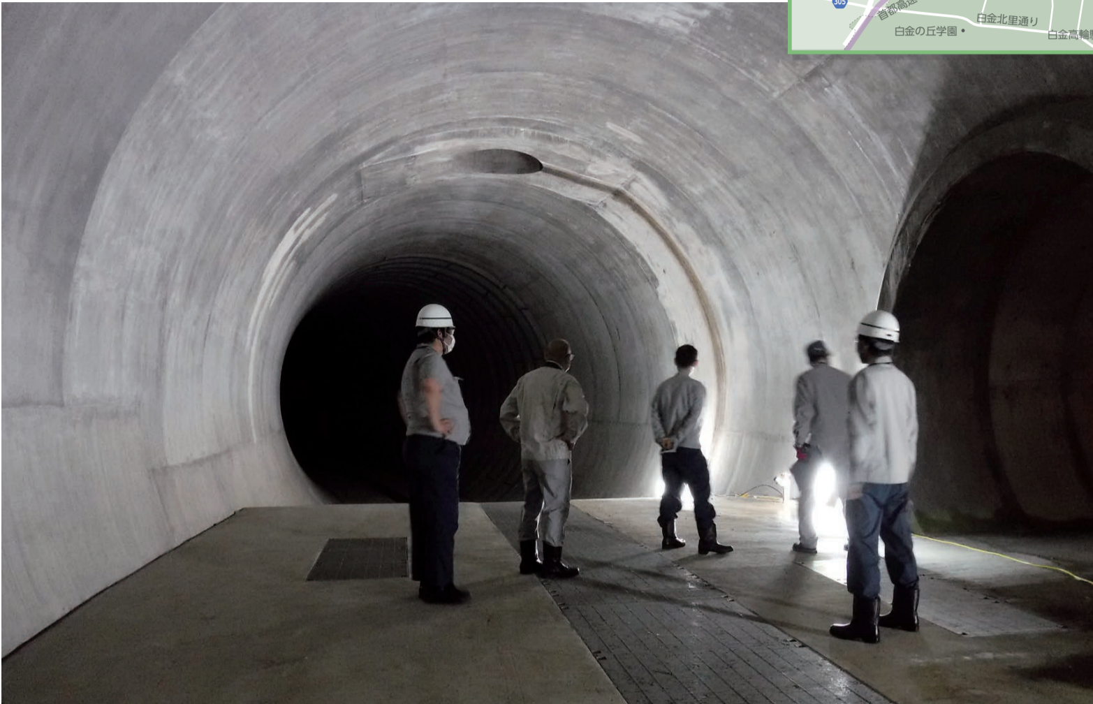
調節池トンネル内の様子
