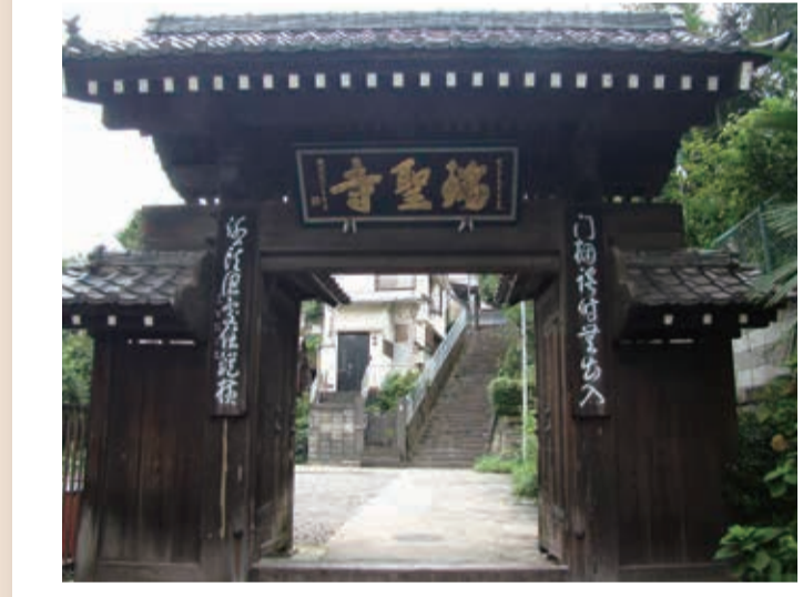
門(旧裏門) 切妻造棧瓦葺の高麗門 3 木造平屋建で19世紀中期に建造。古くは目黒通りに位置していた
